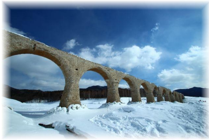
- タウシュベツ川橋梁 -
