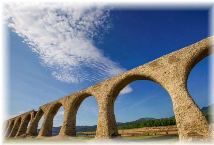
- タウシュベツ川橋梁（上士幌町） -
